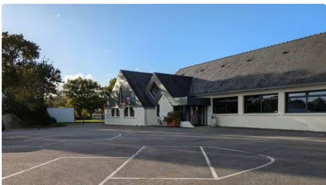
Le parking de la salle La Bruyère, à Molac (Morbihan), se prépare à recevoir des ombrières qui produiront de l'électricité en photovoltaïque solaire pour une opération d'autoconsommation collective d'électricité. | OUEST-FRANCE
