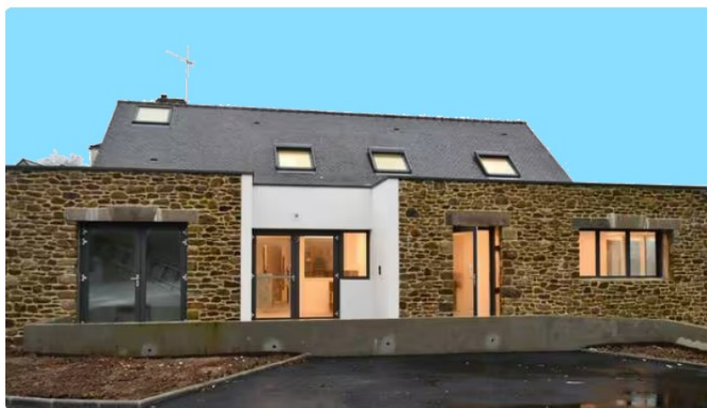
En fin de travaux, la Maison d'Assistants maternelles ouvrira ses portes pour une visite le samedi 16 décembre, avant d'accueillir ses premiers enfants au début de l'année 2024. | OUEST-FRANCE
