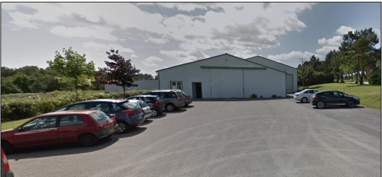
Bâtiment ouest du site de Sulniac.
