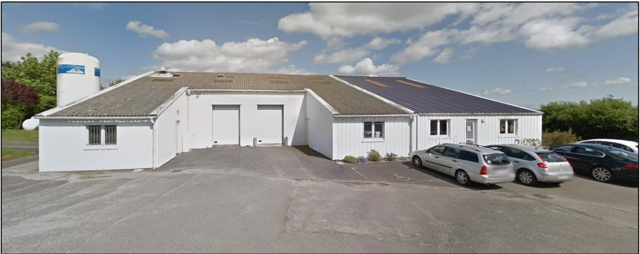
Bâtiment est du site de Sulniac.
